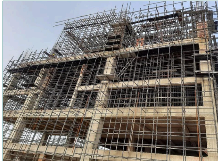
Gypsum Dewatering Bldg.
